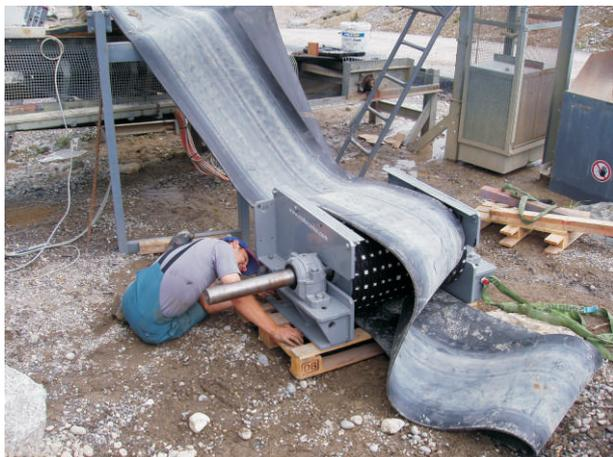
Einfacher Einbau der Kopfstation in einem geschlossenen Gurt dank modularer Bauweise mit leichtem Zwischenflansch. Anpressrolle unten demontieren, unter Gurt legen, Kopfstation mit Antriebsrolle auf Gurt setzen, Anpressrolle anschrauben, komplette Kopfstation an Zwischenflansch heben, mit Locheisen ausrichten, 2mal 6 Stück Schrauben M16 anziehen, fertig !
